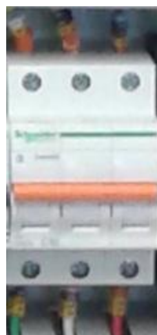
Figura 34: Interruptor Termo magnético tripolar 40
